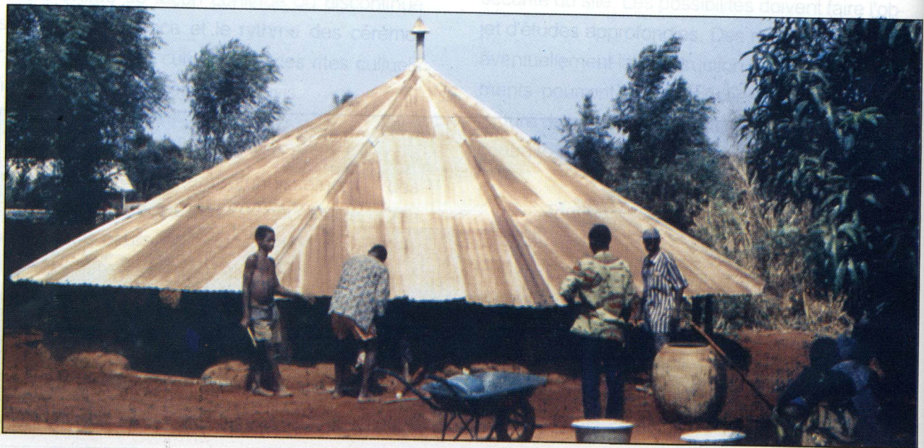
Travaux sur le tombeau d'AKABA, réalisé en partenariat avec ses descendants
