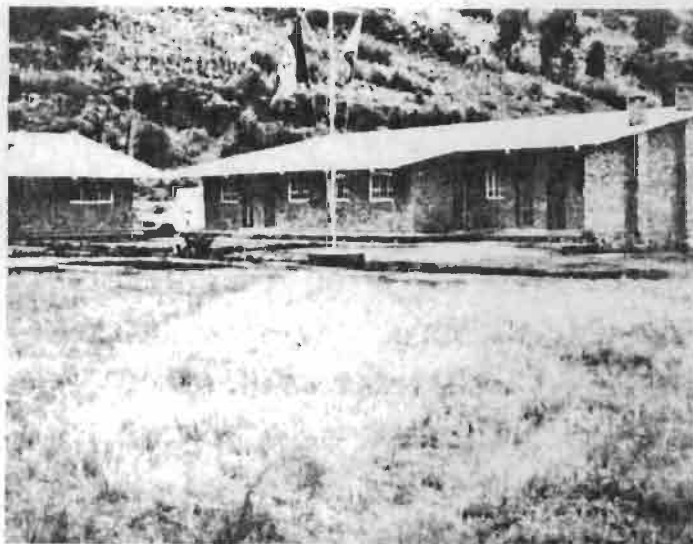
Le centre terminé à Gisenyi en 1979
